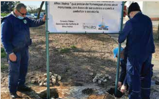
APOIO NA CONSTRUÇÃO DO MONUMENTO MARIA LAMAS
