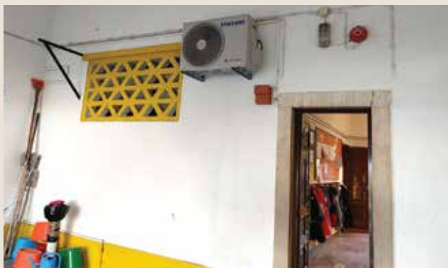
COLOCAÇÃO DE AR CONDICIONADO NA EB1 DE ALHOS VEROS
