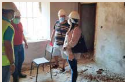
VISITA ÀS OBRAS NA IGREJA
