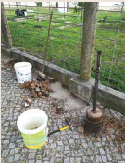
ARRANJOS DE CALÇADA
