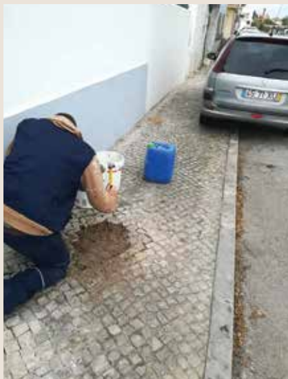
ARRANJOS DE CALÇADA
