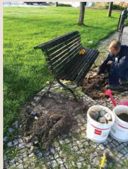
ARRANJOS DE CALÇADA
