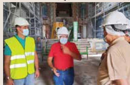
VISITA ÀS OBRAS NA IGREJA
