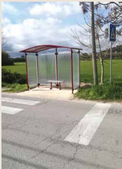
COLOCAÇÃO DE ABRIGOS
